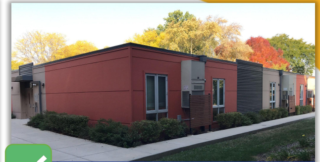
更换后的模块化建筑
