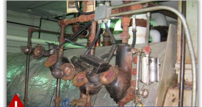
分配管道系统被腐蚀
