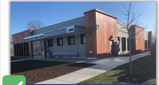
新建/更换后的模块化建筑
