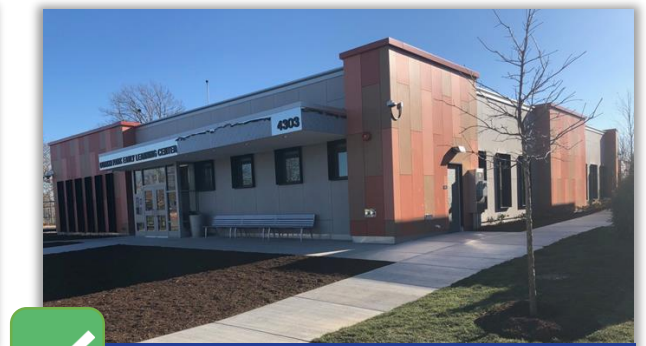
新建/更换后的模块化建筑
