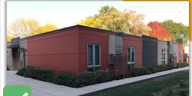
更换后的模块化建筑
