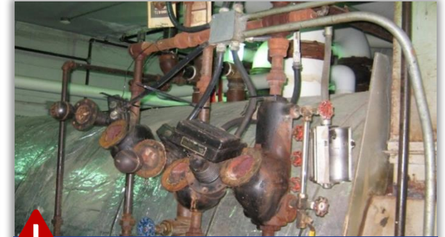
分配管道系统被腐蚀
