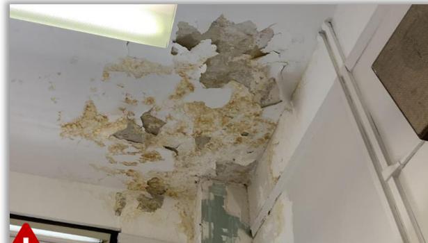
石膏/内部装修破损
