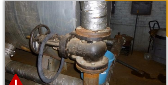
供热分配管道系统损坏
