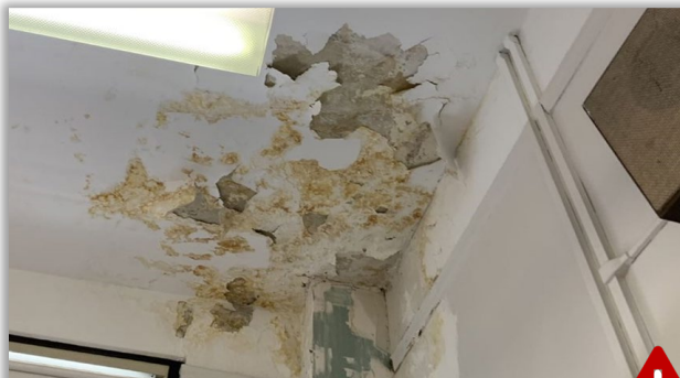
الجص/التشطيبات الداخلية المعطلة
