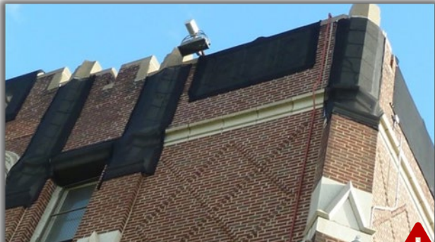
استقرار مؤقت لتآكل الطوب
